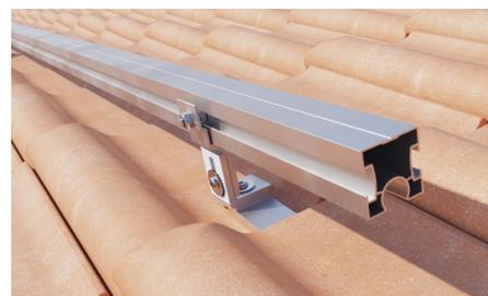
Die Hammerkopfschraube ist nun im Montageprofil eingerastet. Ziehen Sie die Kontermutter auf der Hammerkopfschraube des äußersten Dachhakens fest, sodass sich das Profil nicht mehr drehen oder vom Dachhaken abrutschen kann.
